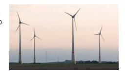
Die mittlere Windgeschwindigkeit in Nabenhöhe soll 7,6 m/s betragen. Der langjährige mittlere Nettoertrag laut Prognose liegt nach Parkwirkungsgrad und 10 % Abschlägen bei 45,6 Mio. kWh.
