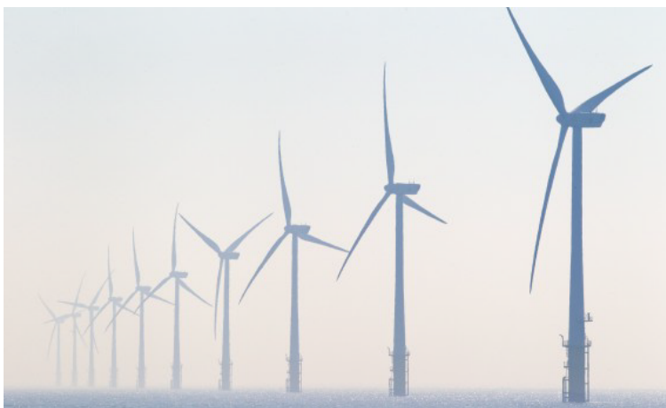
Windturbines in het offshore windpark Egmond aan Zee (OWEZ), het eerste grote windpark dat in de Noordzee voor de Nederlandse kust is gebouwd. Foto ANP / Koen Suyk
