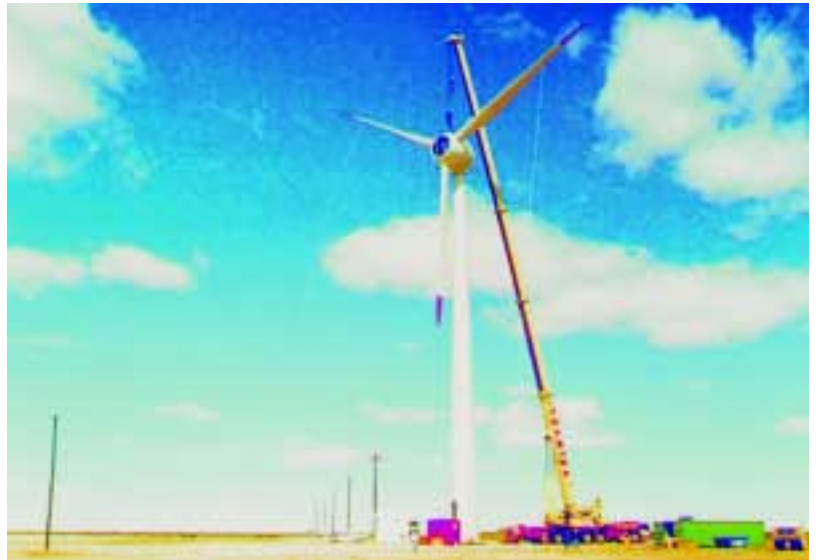
Aufbau einer E-40 in Brasilien.
