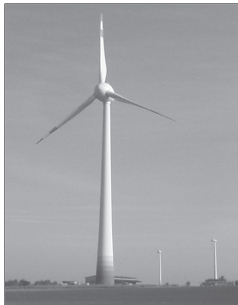
E-112 von Enercon (4,5 MW) für den Einsatz auf hoher See, nun auch für den Einsatz im Binnenland beworben (Foto: Tilman Kluge, Egeln 9/2002)
